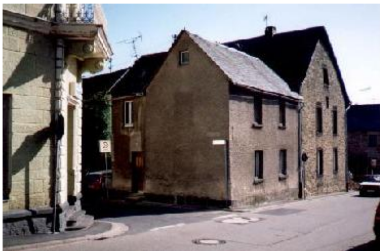
Gebetshaus in der Koblenzer Straße
